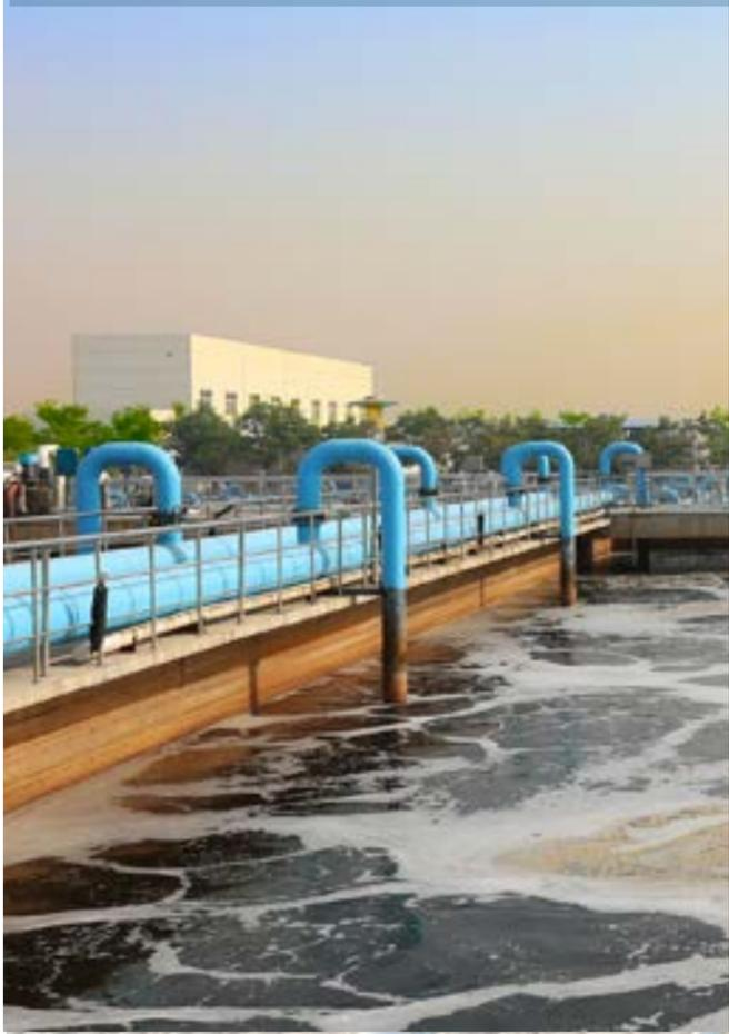
Es esencial eliminar las partículas en suspensión para que el tratamiento biológico, principalmente, funcione. El pretratamiento consiste en almacenar el agua y permitir que las partículas sedimenten, junto con los organismos patógenos y se acumulen en el fondo del tanque. Luego pasa a través de sucesivas capas de arena de distinto grosor que retienen otro porcentaje de impurezas.
